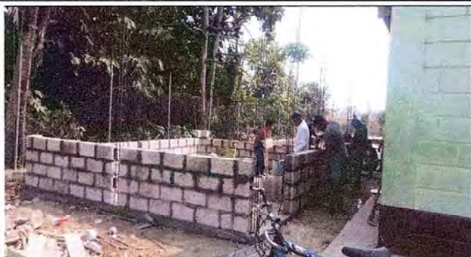
Foto 1: Proceso de rehabilitación de cocina.
