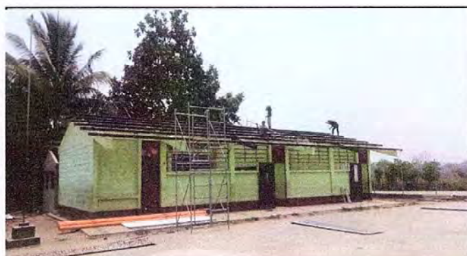
Foto 4: En esta fotografía se aprecia el mantenimiento que se le hizo a las vigas
