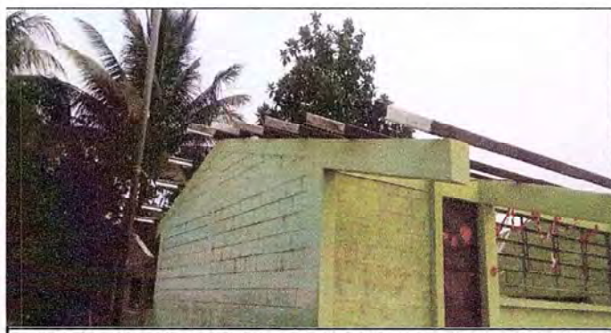
Foto 5: Foto de la añadidura que se le hizo a las vigas mismas que se le dieron su respectivo mantenimiento
