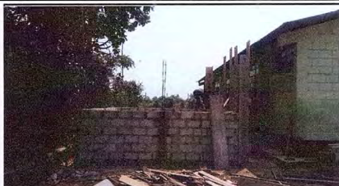
Foto 2: Levantado de muro de rehabilitación de cocina.
