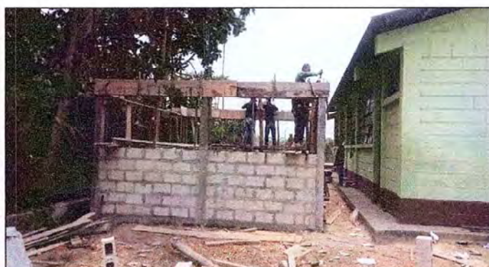
Foto 3: Proceso de instalación del entechado de la rehabilitación de cocina.
